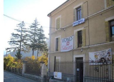
L'ancienne maison des chefs de gare occupée à Veynes © LF
